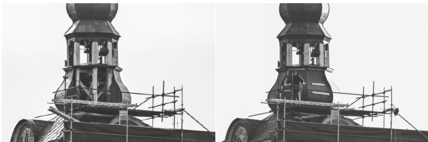
Oprava střechy věže kostela
